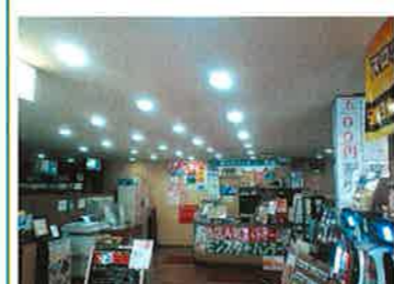
ホール・カウンター基礎照明
